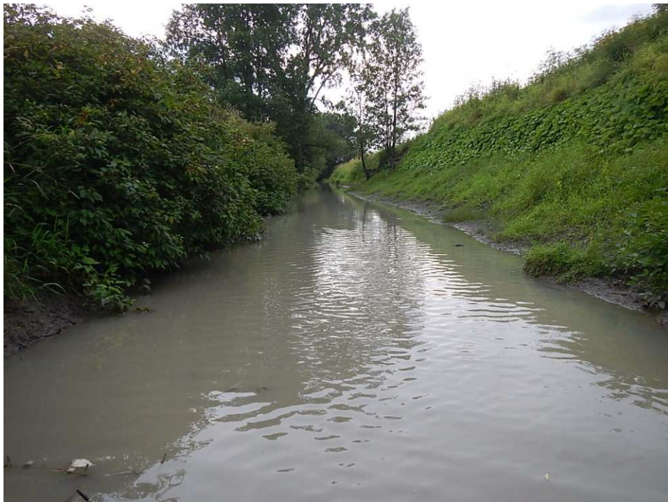
Photo 2 : Vue vers l'amont au site de franchissement
