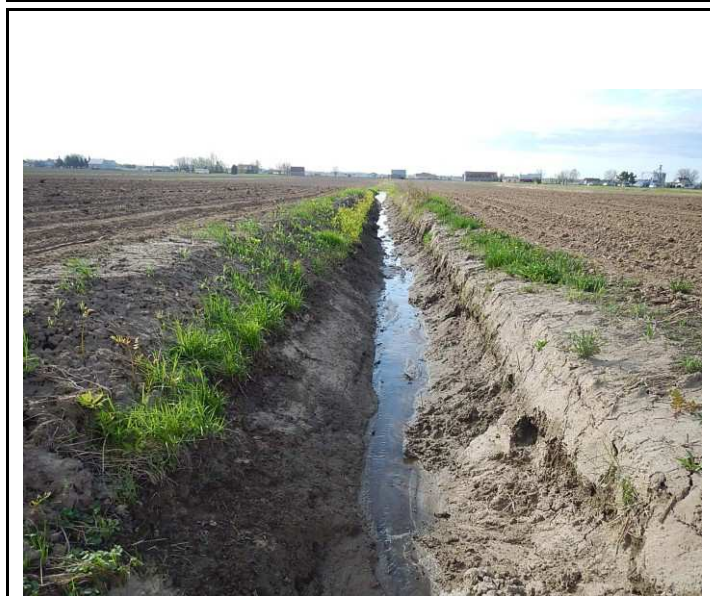
Photo 1 : Vue vers l'aval au site de franchissement
