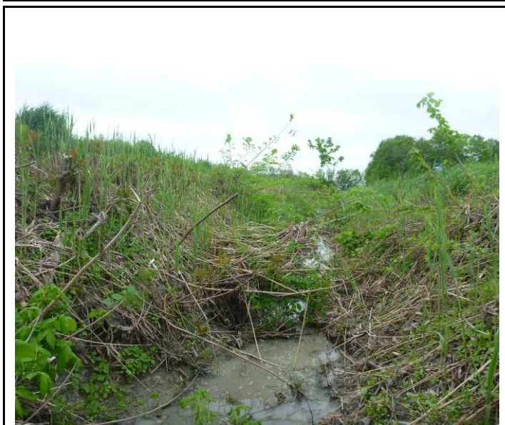
Photo 1 : Vue vers l'aval au site de franchissement
