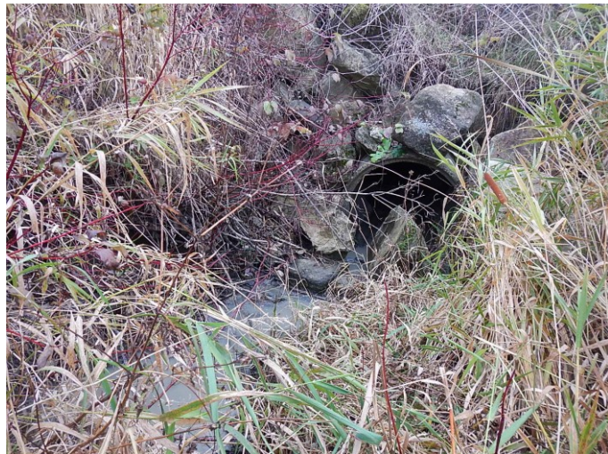
Photo 1 : Vue vers l'aval au site de franchissement
