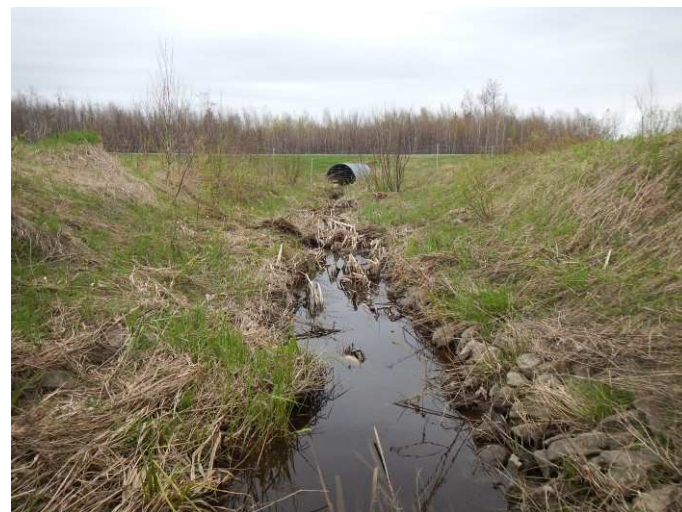
Photo 1 : Vue vers l'aval au site de franchissement
