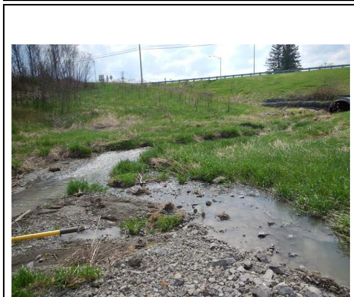
Photo 1 : Vue vers l'aval au site de franchissement
