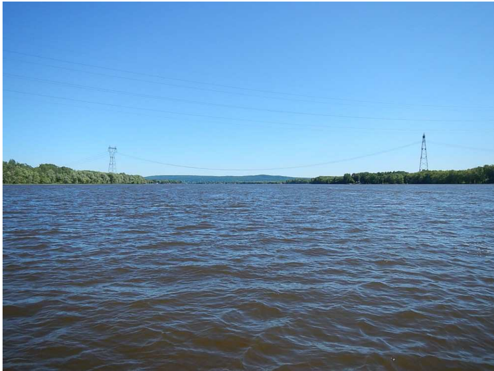
Photo 1 : Vue vers l'aval au site de franchissement
