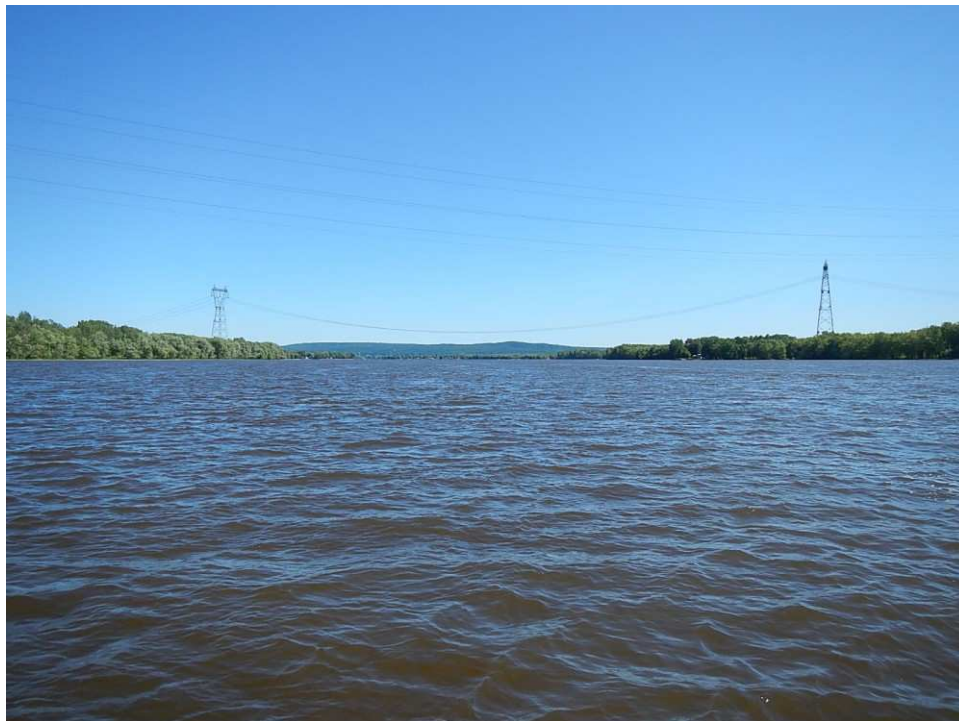
Photo 1 : Vue vers l'aval au site de franchissement
