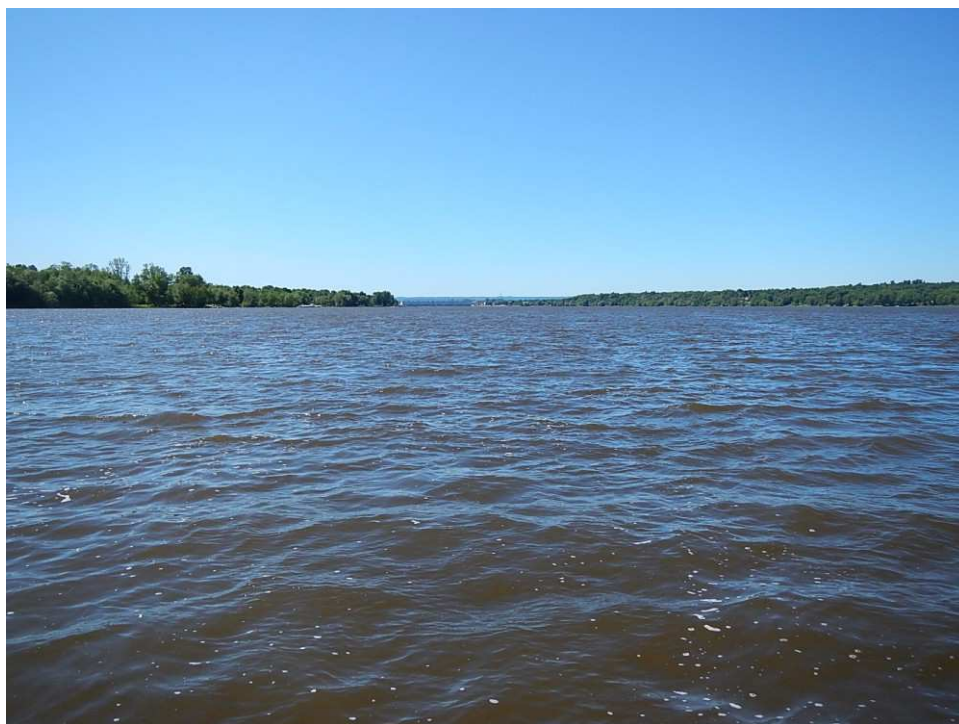
Photo 2 : Vue vers l'amont au site de franchissement
