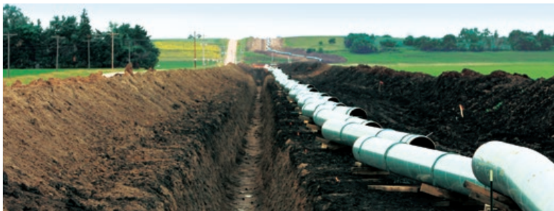
Défrichage et nivellement de la servitude. La couche arable est conservée de manière à pouvoir être retournée après la construction.
