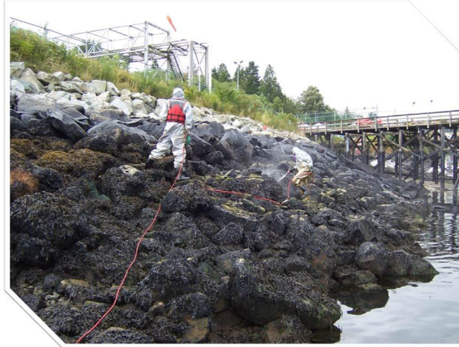
Figure 6 Application de nettoyeur de plage sur les littoraux rocheux à Westridge ( Western Canada Marine Response Corporation )
