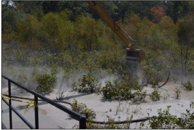
Figure 8 Application du produit PMFI Organoclay (CETCO™) sur la végétation de la crique Dawson (Arcadis, 2015)
