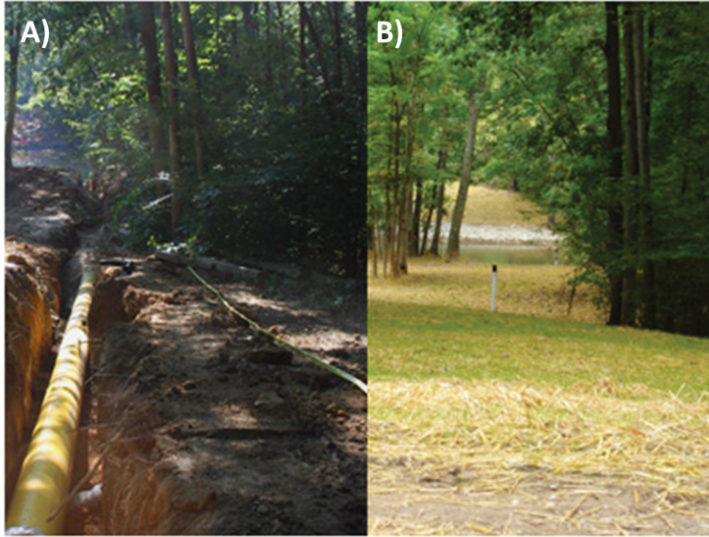
Figure 4. 18. Installation d'un gazoduc. A) Tranchée servant à enfouir le gazoduc dans le sol de 1 à 2 mètres de profondeur. B) Gazoduc souterrain recouvert (Mid-Ohio pipeline services, 2012).
