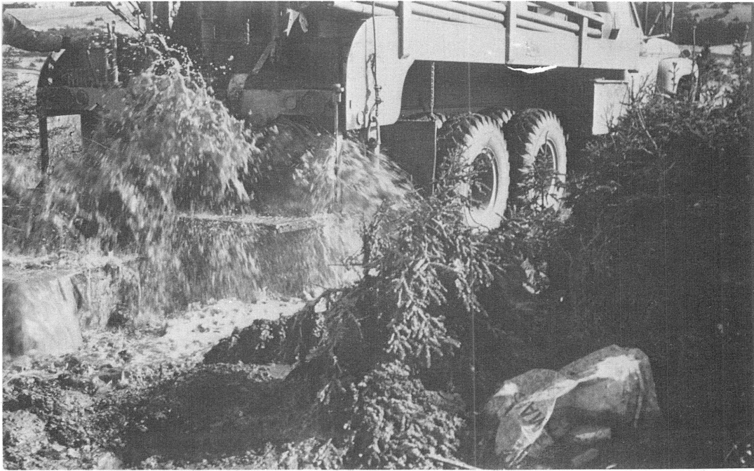
A—Développement d'un puits par air comprimé
