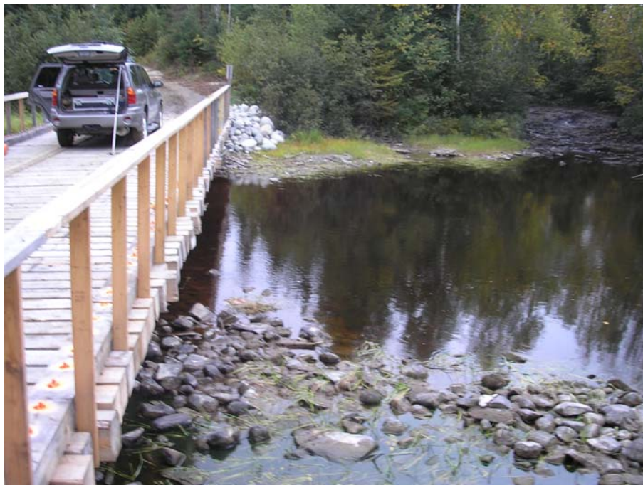
Photo 12 Pont au-dessus de la rivière Piché (site de jaugeage), le 12 septembre 2007
