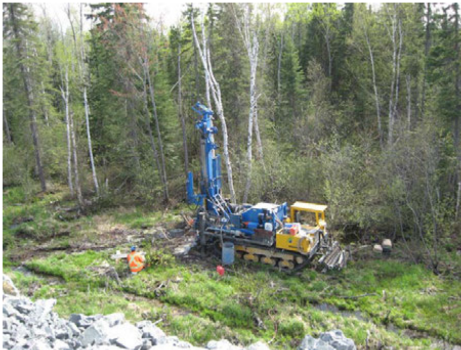
Photo 6 : Mise en place du coulis ciment-bentonite
