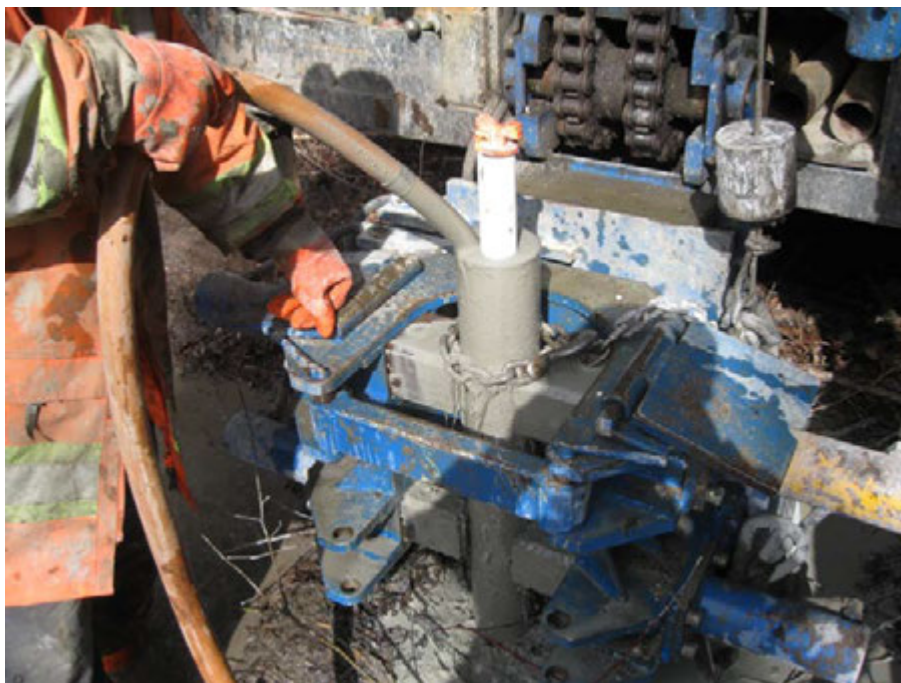
Photo 6 : Mise en place du coulis ciment-bentonite
