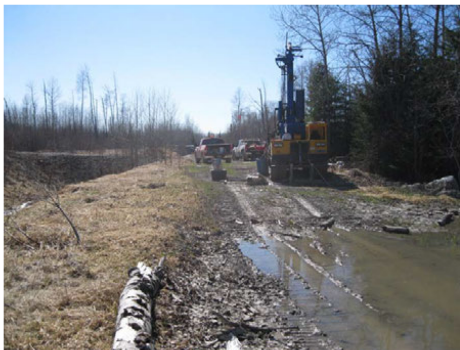
Photo 2 : Travaux de forage dans le secteur de la halde à stériles et du parc à résidus
