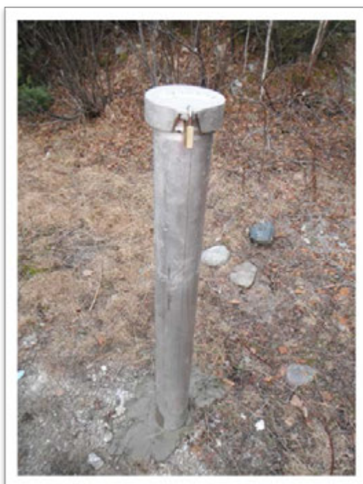
Figure 8: Remplacement protecteur hors-sol PZ10-07R (secteur Barnat)
