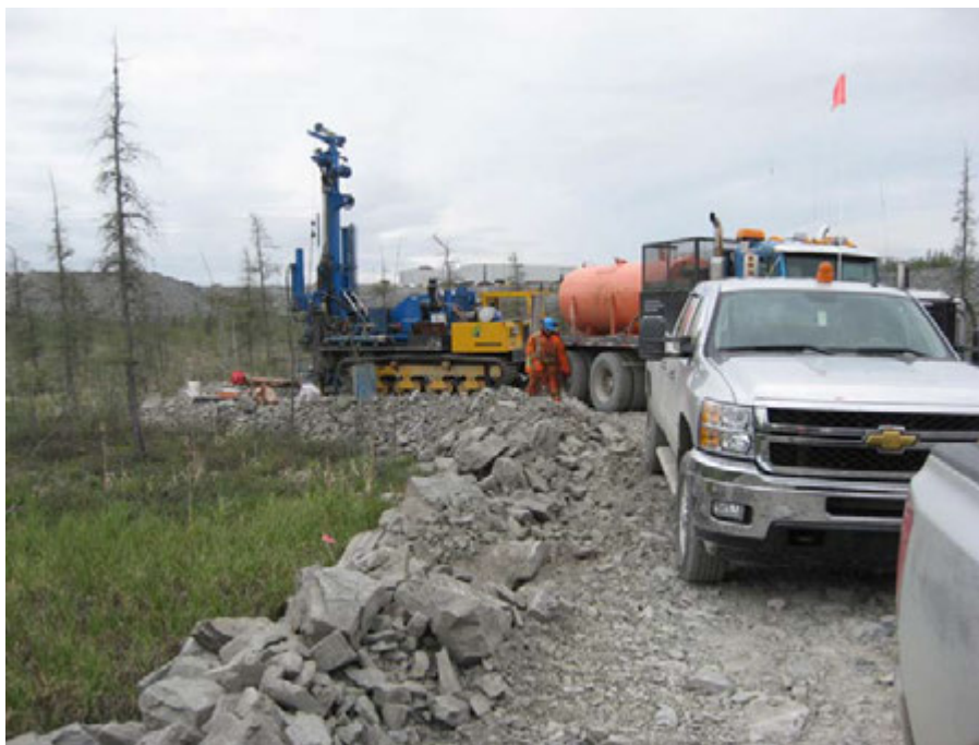
Photo 4 : Travaux de forages dans le secteur de la halde haute teneur
