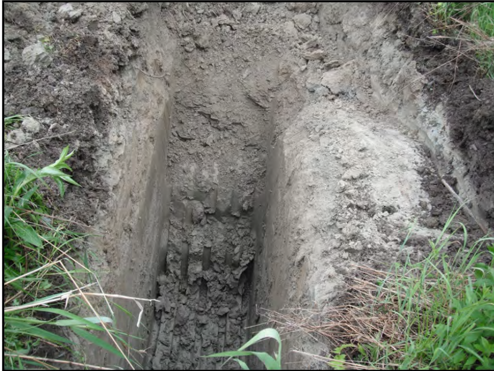
Photo 29 – Tranchée d'exploration 15-TE-22. (11 juin 2015)
