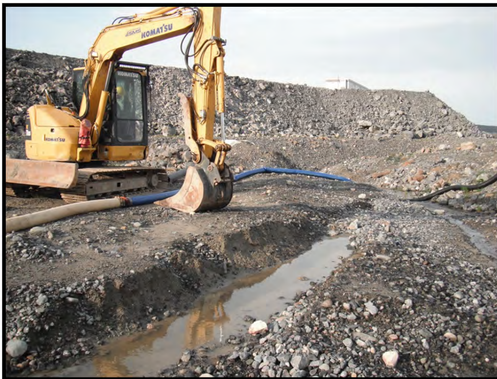
Photo 1 – Localisation de la tranchée d'exploration 15-TE-01. (10 juin 2015)
