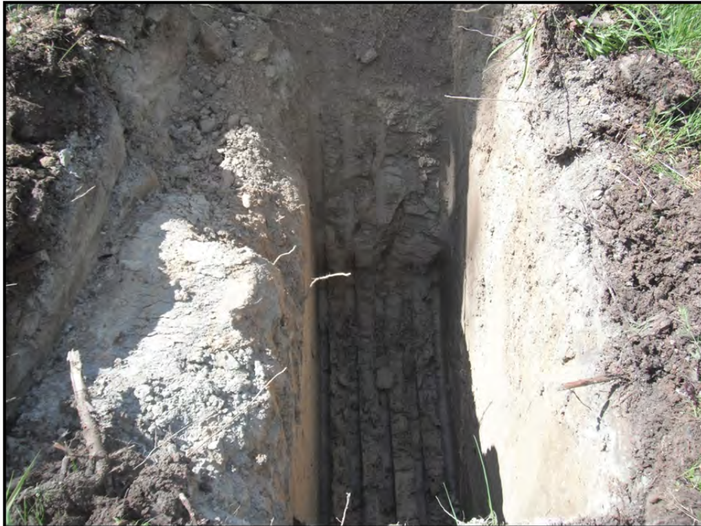
Photo 28 – Tranchée d'exploration 15-TE-21. (11 juin 2015)
