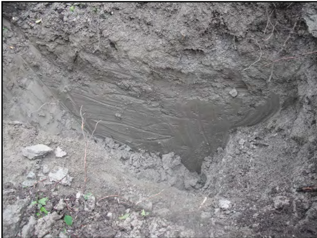
Photo 32 - Tranchée d'exploration 15-TE-25. (10 juin 2015)
