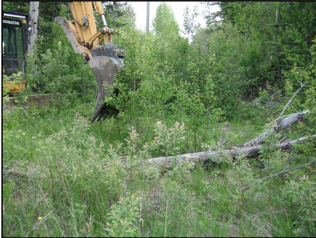
Photo 5 – Localisation de la tranchée d'exploration 15-TE-02. (20 juin 2015)
