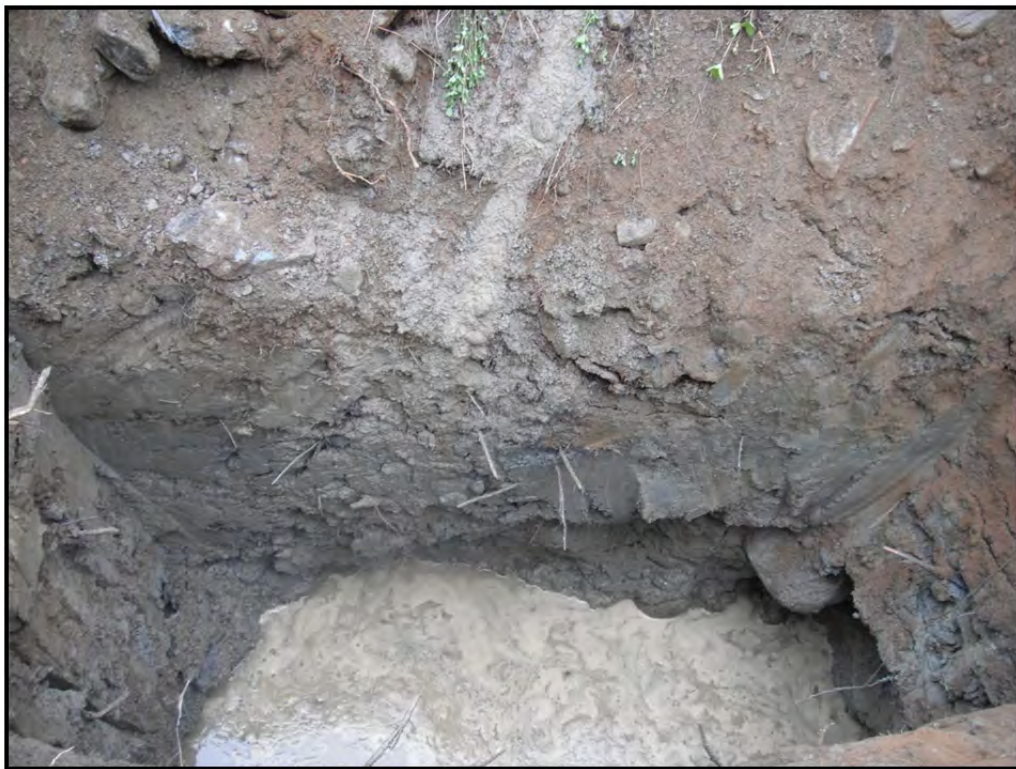
Photo 16 - Tranchée d'exploration 15-TE-06. (10 juin 2015)
