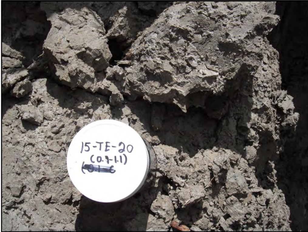
Photo 27 – Tranchée d'exploration 15-TE-20. (11 juin 2015)
