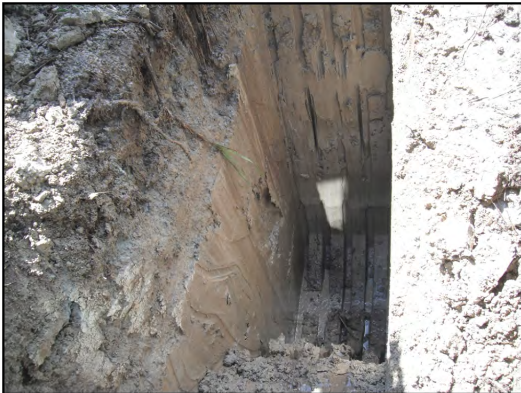
Photo 26 – Tranchée d'exploration 15-TE-19. (11 juin 2015)
