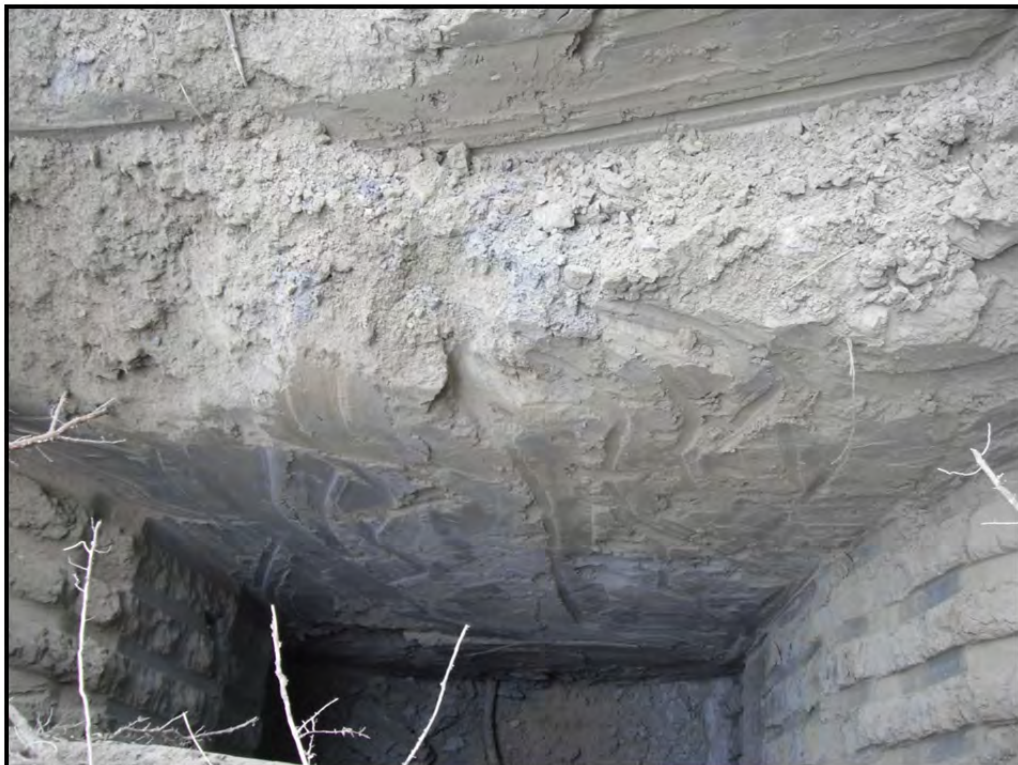
Photo 10 - Tranchée d'exploration 15-TE-03. (10 juin 2015)
