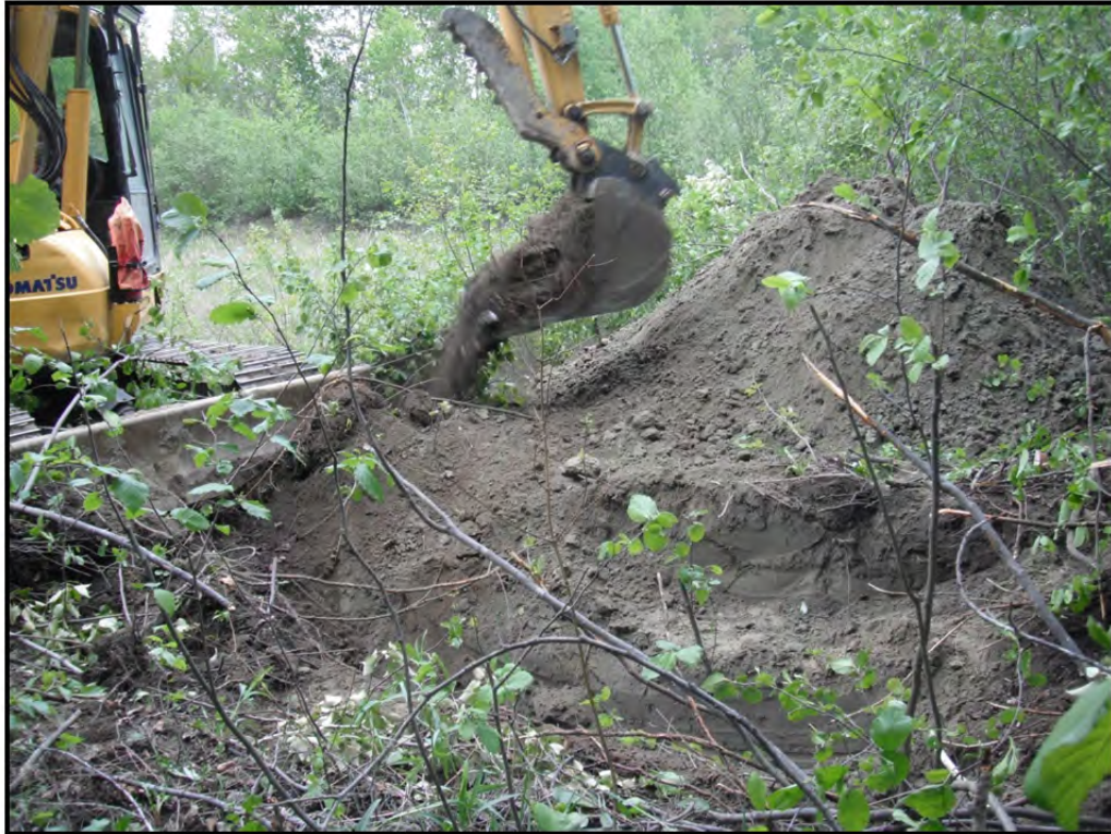
Photo 9 – Tranchée d'exploration 15-TE-03. (10 juin 2015)
