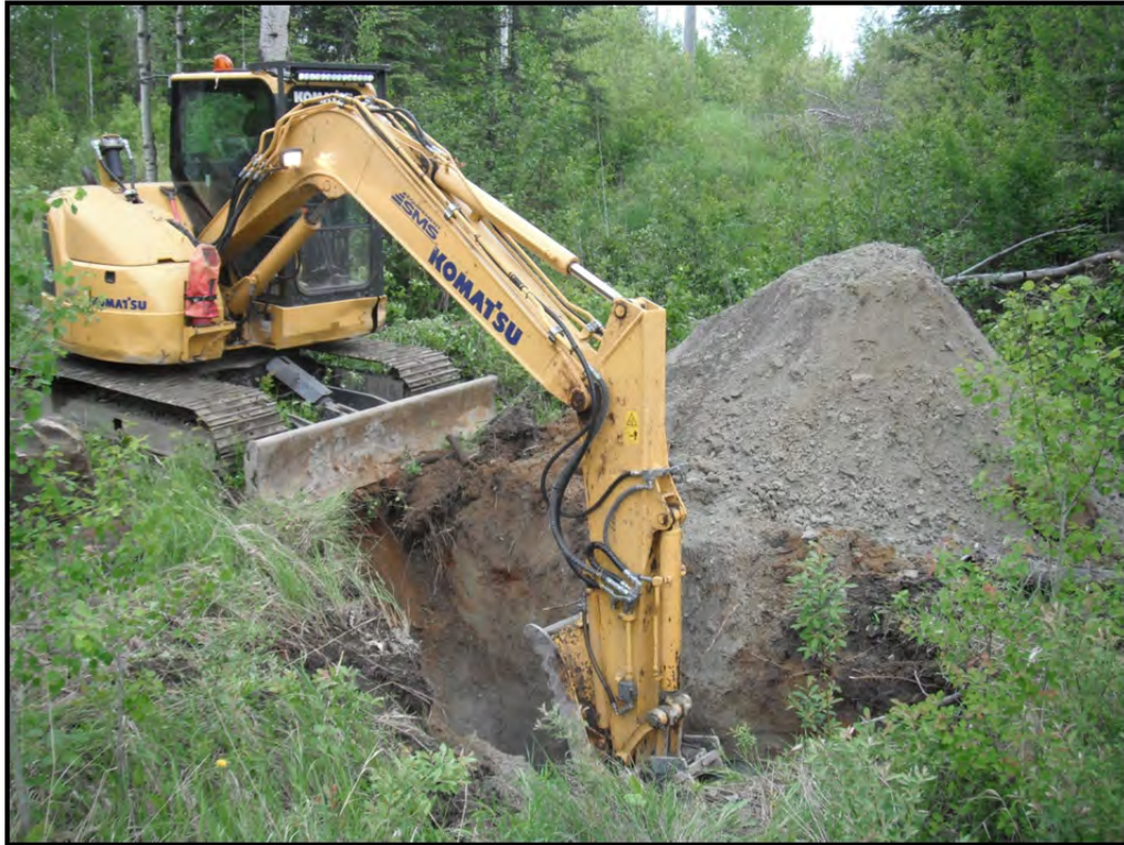
Photo 7 – Tranchée d'exploration 15-TE-02. (10 juin 2015)
