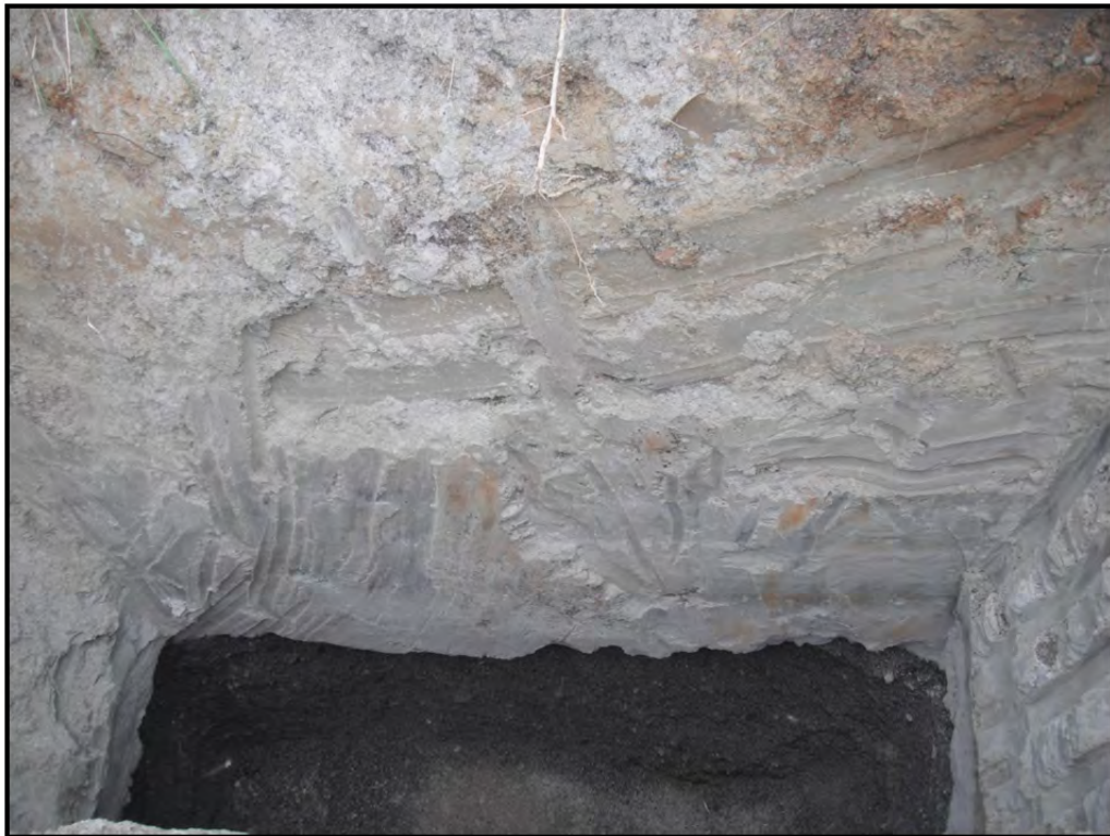
Photo 8 - Tranchée d'exploration 15-TE-02. (10 juin 2015)
