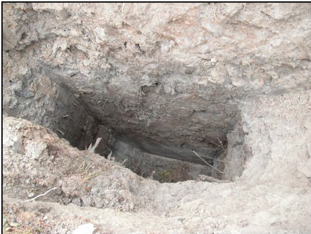
Photo 30 - Tranchée d'exploration 15-TE-23. (10 juin 2015)
