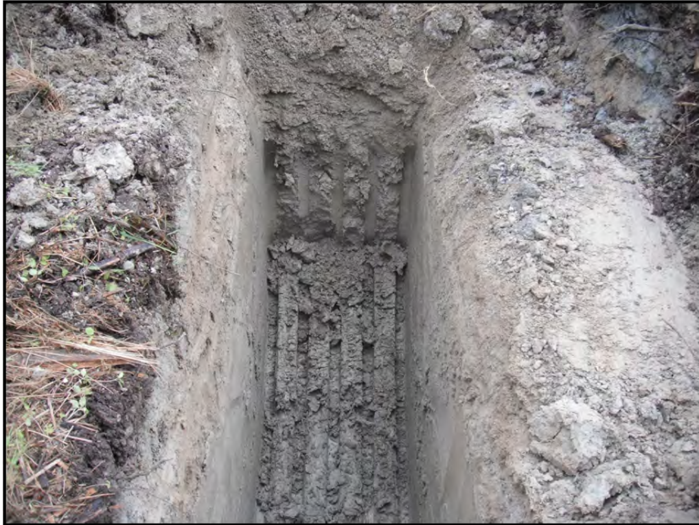
Photo 25 – Tranchée d'exploration 15-TE-18. (11 juin 2015)
