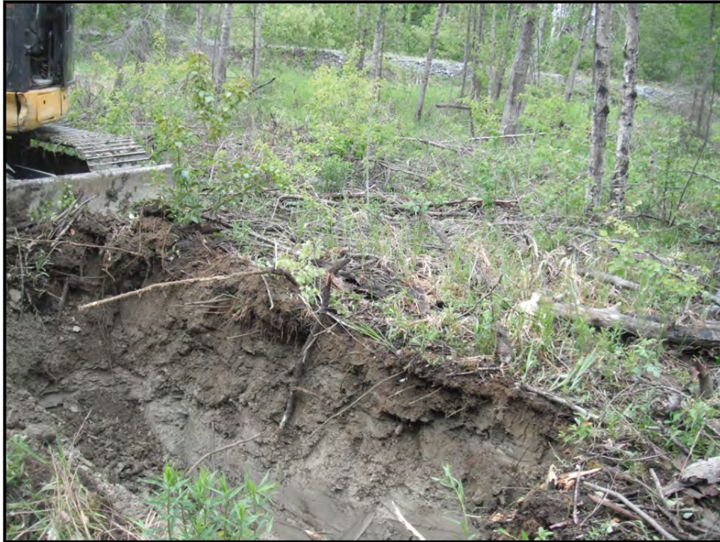
Photo 17 – Tranchée d'exploration 15-TE-07. (10 juin 2015)
