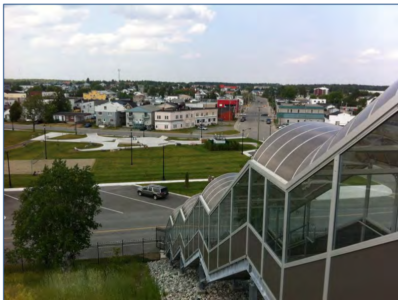
Photographie 6-4 Belvédère d'observation des opérations minières
