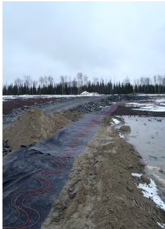
Photographie 4: Installation du câble en serpent dans le géotextile.
