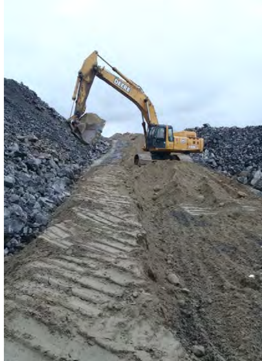
Photographie 7: Protection du câble avec une couche de sable.
