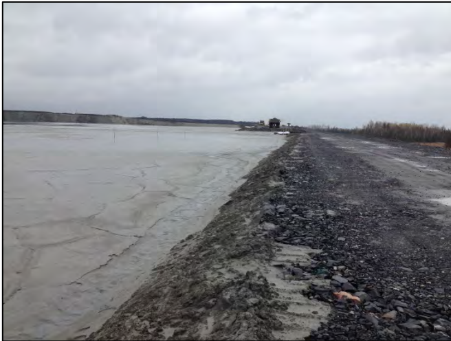
Illustration 2 : Construction du rehaussement
