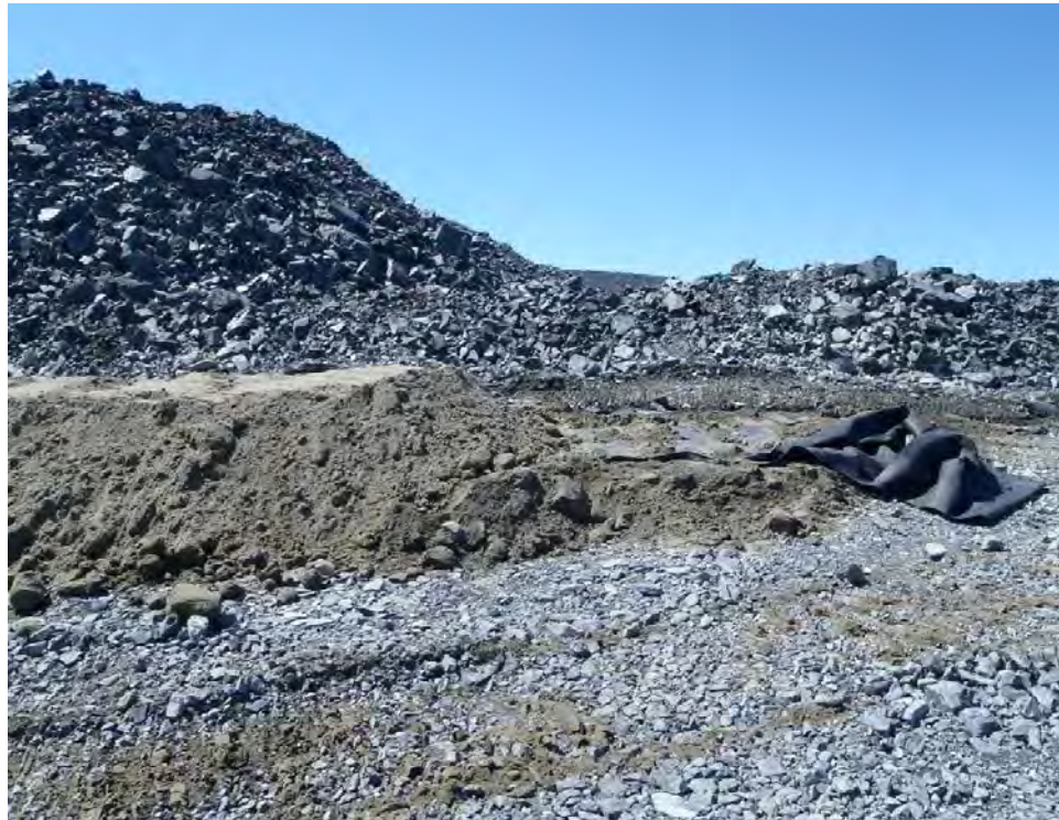
Photographie 6: Protection du câble avec une couche de sable.
