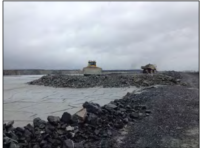
Illustration 3 : Construction du rehaussement
