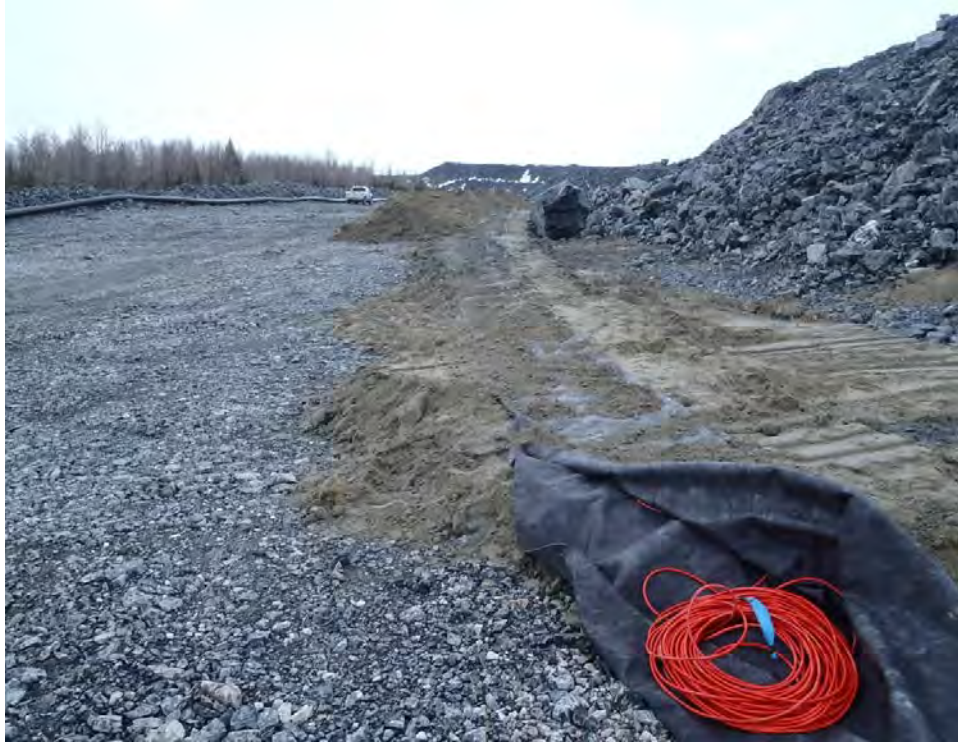
Photographie 3: Installation du câble du piézomètre à corde vibrante dans le géotextile.
