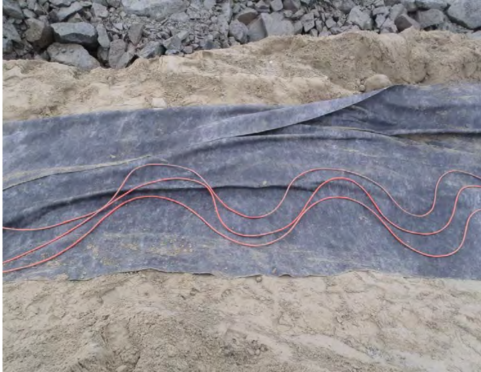
Photographie 5: Installation du câble en serpent dans le géotextile.
