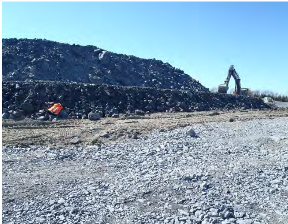
Photographie 8: Protection du câble avec une couche de stériles miniers.
