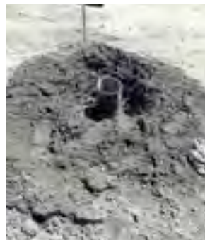
Trou de forage avec additif de forage
