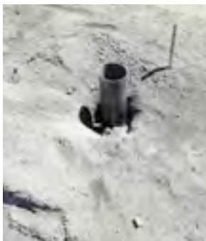
Trou de forage sans additif de forage
