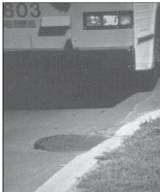
Figure 2. Un autobus ou un camion qui passe sur une irrégularité de la chaussée produit des vibrations.
