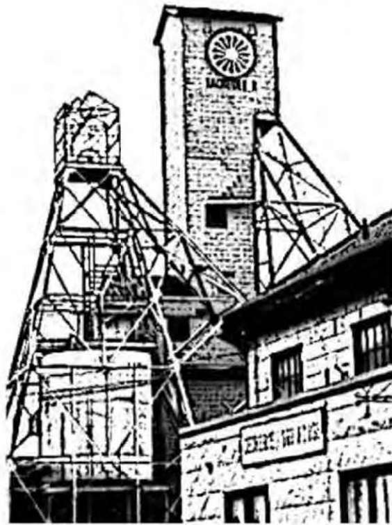
Figure 6.1 b Site historique de l'Ancienne-Mine-Lamaque
