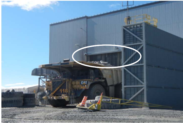
Installation de rideaux au concasseur
