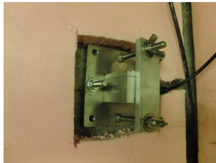
Figure 8 : Capteur de vibration installé sur un mur porteur de l'habitation #1
