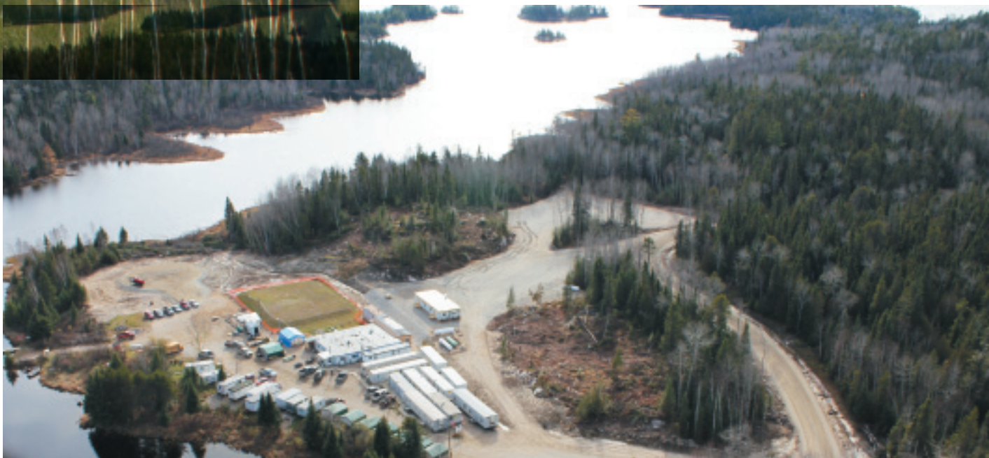
Installations à Hammond Reef
