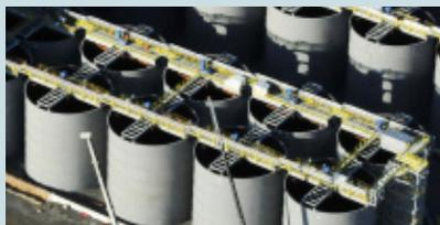
Une fois installé, l'équipement de l'usine de traitement a été mis à l'essai au cours du mois d'octobre. En novembre, les conduits et les cuves ont dû subir une série d'essais d'étanchéité au terme des essais préliminaires.
