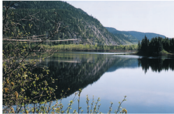
Lignes existantes sur la rive nord du lac Vallant
