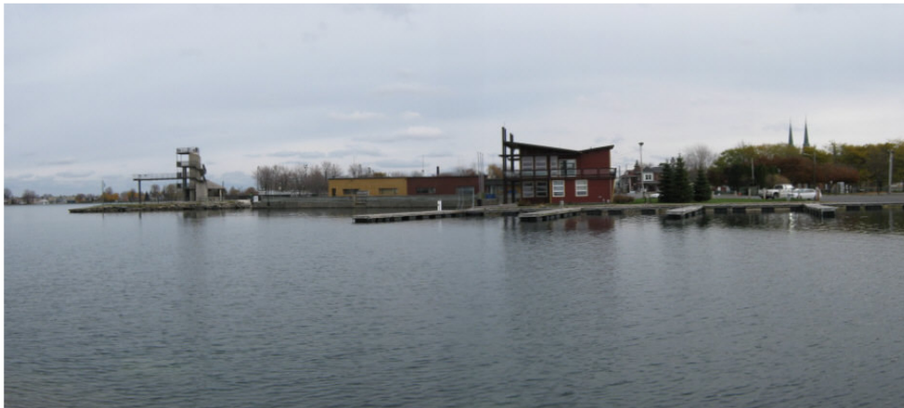
Photo 7 : Quai flottant 11 vu depuis la langue de terre fermant le bassin de la marina. Nous apercevons le bâtiment d'accueil en arrière-plan.
