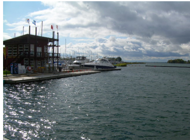
Photo 4 : Bâtiment d'accueil avec poste d'essence au premier plan à gauche. Nous apercevons le quai flottant 11 en arrière-plan.
