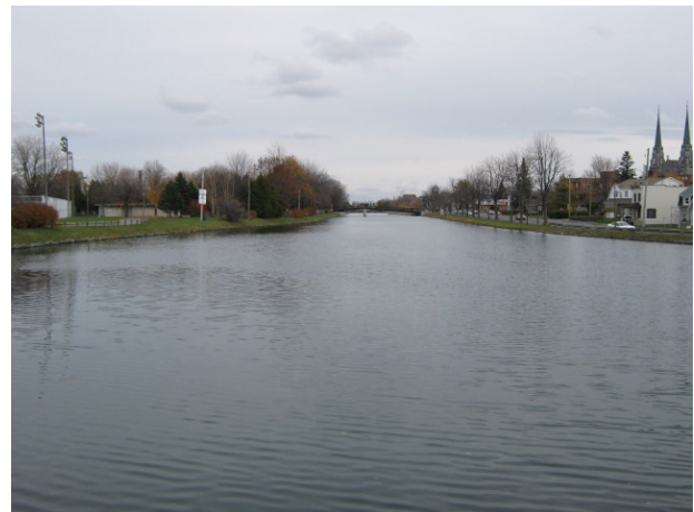
Photo 12 : Ancien canal de Beauharnois récemment rouvert à la navigation, vu depuis la passerelle reliant le parc Delpha-Sauvé.
