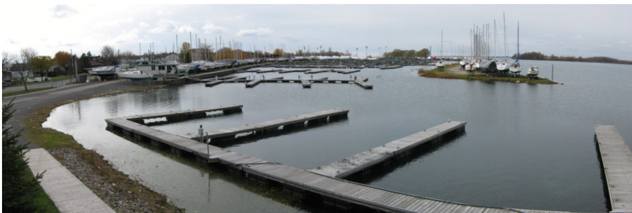
Photo 8 : Quai flottant 11 vu depuis le bâtiment d'accueil de la marina. Nous apercevons, en arrière-plan, le quai flottant 10, à gauche, et la langue de terre, à droite.
