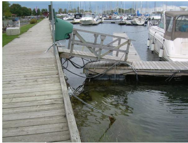
Photo 6 : Raccordement du quai flottant 10 au quai fixe en rive. Le quai flottant 9 est visible en arrière-plan.
