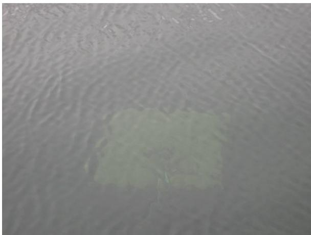
Photo 11 : Bloc de béton submergé pour l'ancrage des quais. Chaque bloc occupe une superficie d'environ 0,74 m<sup>2</sup>.
