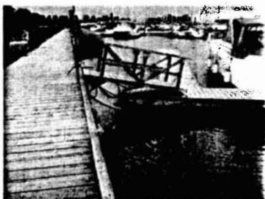
Photo 1 : Raccordement du quai flottant n° 10 au quai fixe en rive. Le quai flottant n° 9 est visible en arrière-plan.
