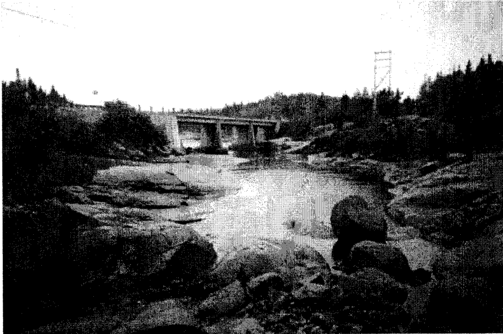
Photo RQC-1.3 : Portion aval du bras gauche (vue vers l'aval).
