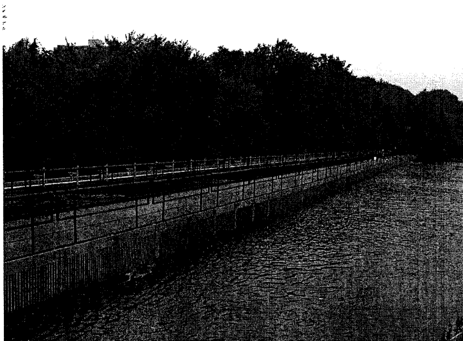
Système de persiennes implanté à la centrale Holyoke, rivière Connecticut
