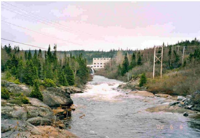
Photo 8-1 Écoulement dans le bras gauche lors d'une crue
