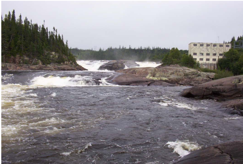
Figure 1 : Site de la 1 e chute de la rivière Magpie et de la centrale désaffectée à droite (photo Alain Saladzius)
