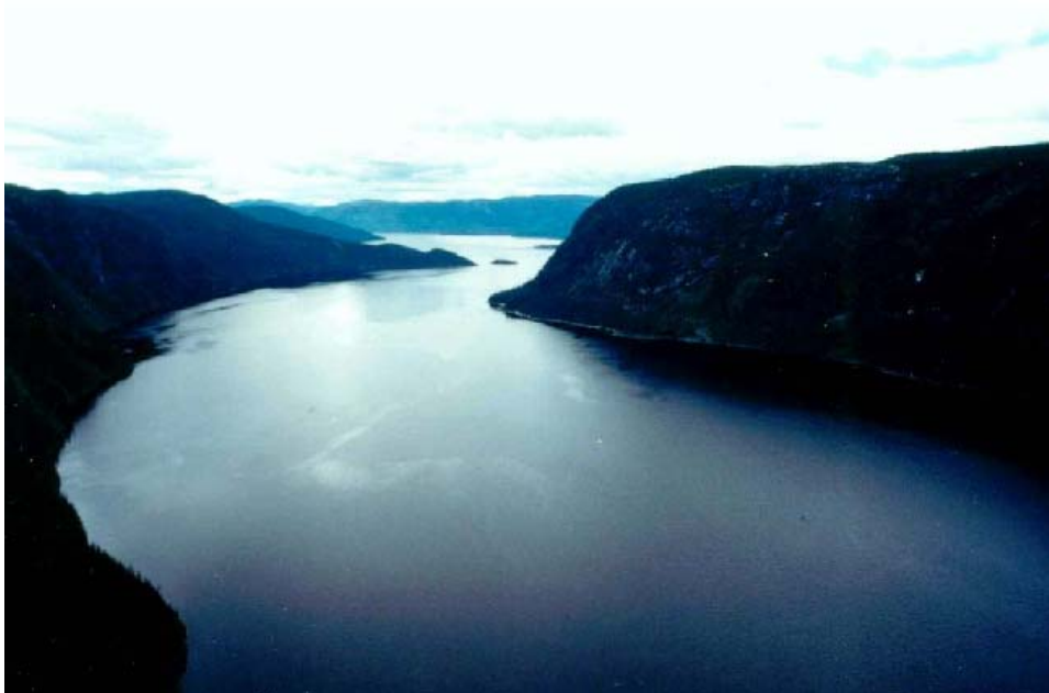
Figure 8 : Vue vers le nord du tronçon central du lac Magpie. Ce secteur est le plus escarpé du lac, avec des flancs dépassant 400 m (photo Sylvain Archambault)
