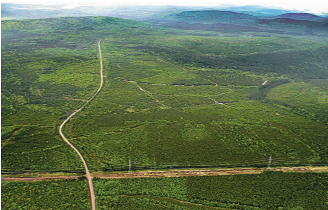
Point de raccordement de la ligne projetée avec la ligne existante dans le TNO de Rivière-Vaseuse Vue vers le nord avec le chemin Bona
