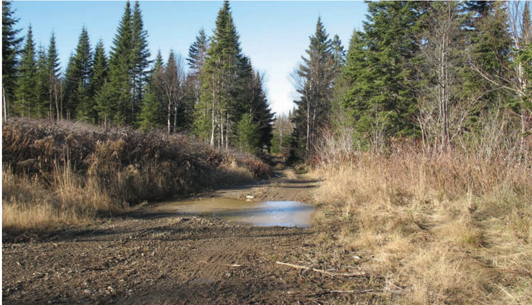
Chemin forestier à la limite du rang 9 (à droite) et du rang 10 (à gauche) dans la municipalité de Saint-Zénon-du-Lac-Humqui – Vue vers le nord à partir du lot 25
