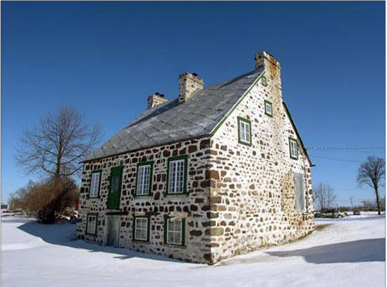
Photo 5.2 La façade arrière de la Maison Poitras.
