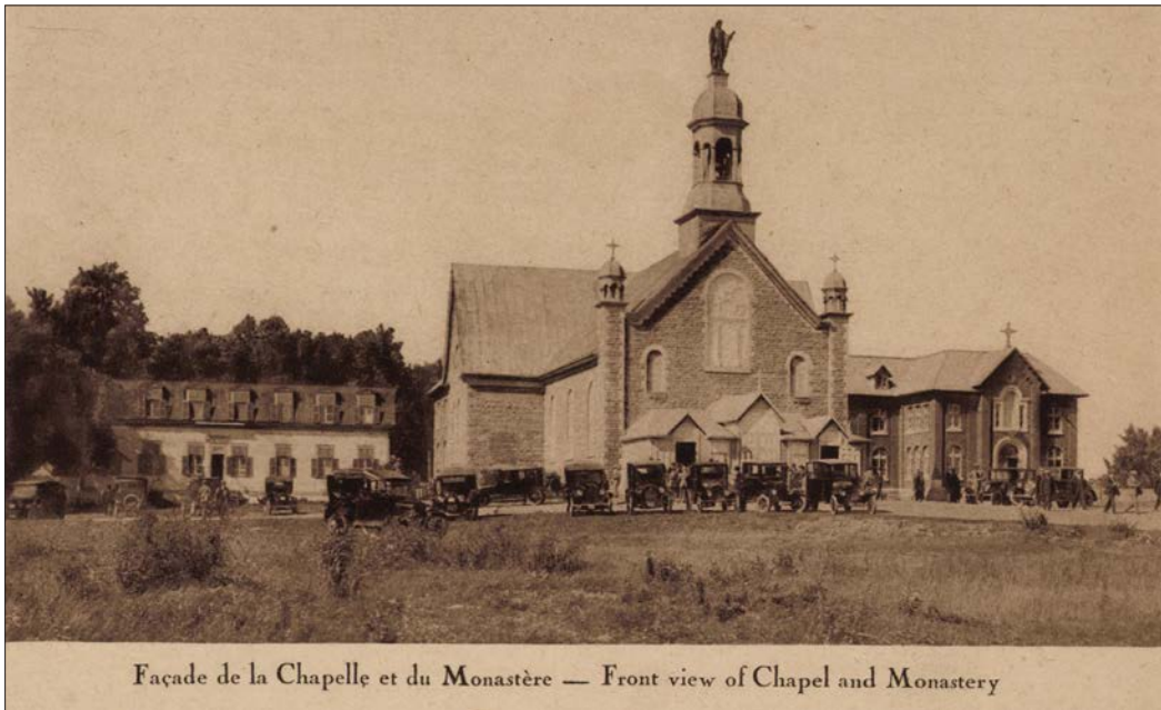
Photo 4.14 Façade de la chapelle et du monastère la Réparation, entre 1923 et 1931.
