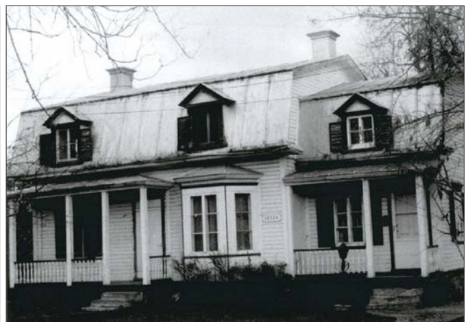
Photo 4.18 Ancienne maison du surintendant du cimetière.
