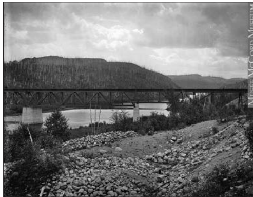
Photo 8.2 Vue du pont ferroviaire de la chute à L'Iroquois. Depuis la rive droite de la Vermillon. Fond Notman, Musée McCord.
