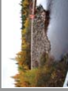
Photo B.4 : Stabilisation par enrochement
