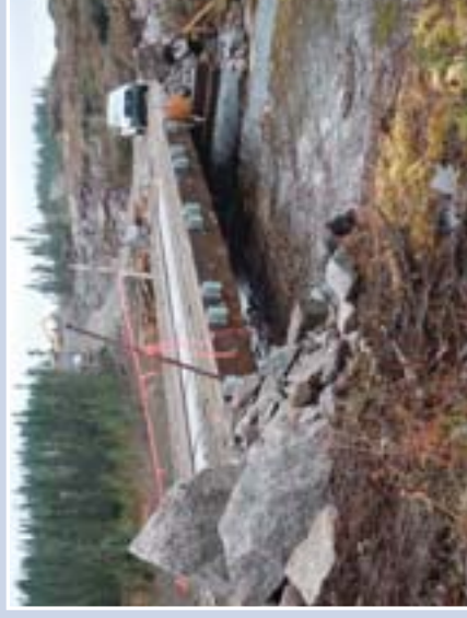
Photo B.2 : Pont provisoire (PP-7) en construction, chantier de la Romaine
