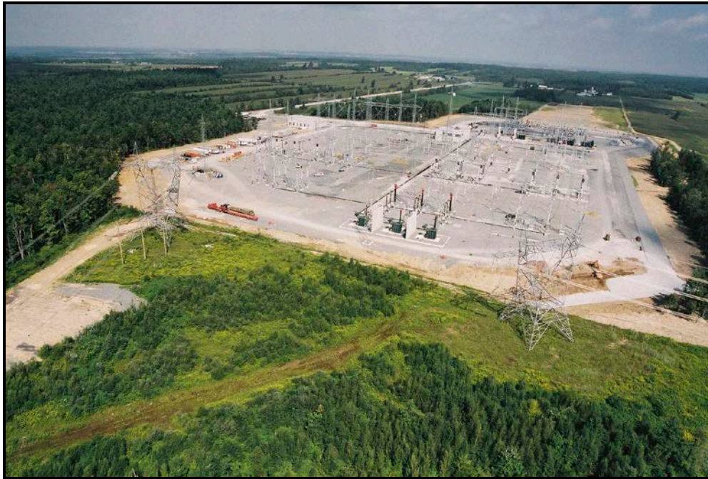
Photo F-1 : Poste de la Montérégie à 735-120 kV
