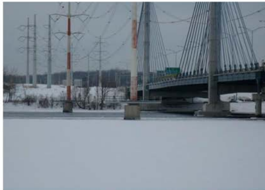
Figure 12 : aucune obstruction à la dérive des glaces créée par la présence du pylône dans l'écoulement (11 janvier 2013)
