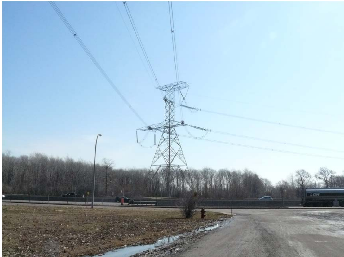
Photo 9-1 : Pylône du circuit 7009 à démanteler le long de l'autoroute 40
