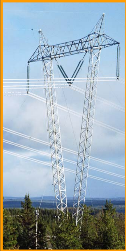
Exemple de pylônes en V haubanés
