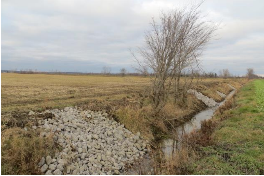
Des aménagements réalisés à Saint-Maurice.
