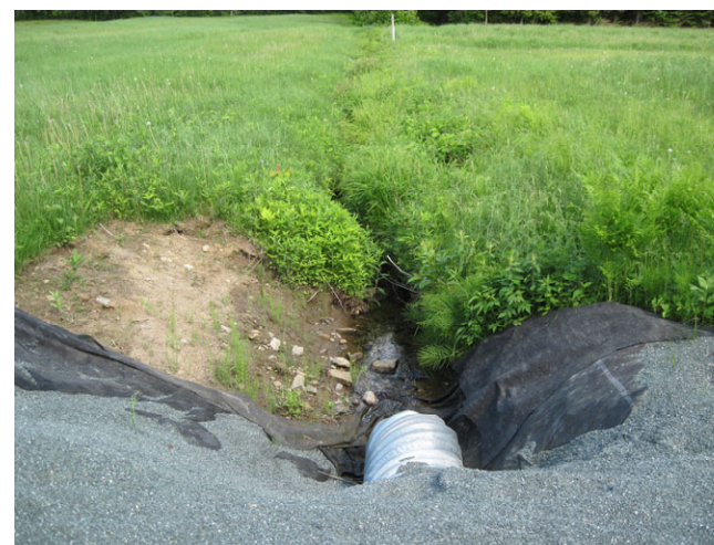
Photo D.2 : Ponceau installé dans un fossé agricole, projet de la ligne Nicolet-Bécancour
