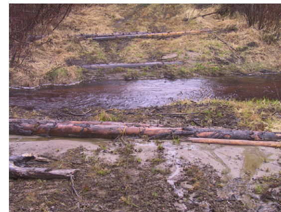
Photo B.11 : Billes de bois laissées en place à la suite du retrait d'un pont provisoire, projet de la ligne Chute-Allard-Rapide-Blanc
