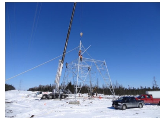
Photo A.6 : Aire de travail sur sol gelé, projet de la ligne Figuery-Palmarolle
