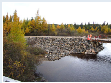
Photo B.3 : Stabilisation par enrochement
