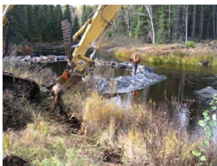
Photo B.7 : Construction d'un atardeau en enrochement
