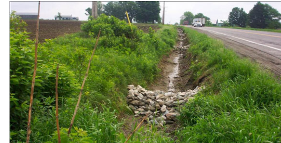
Photo F.8 : Berme en enrochement (source : MTQ, 2014)
