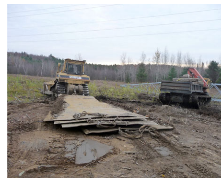
Photo A.7 : Plaques d'acier utilisées pour le déplacement de la machinerie dans une tourbière, projet de la ligne Chénier-Outaouais
