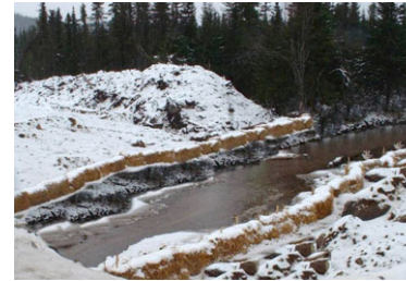
Photo F.12 : Barrière à sédiments en ballots de paille (source : MTQ, 2014)
