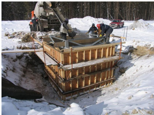
Photo A.5 : Construction d'une fondation en béton sur sol gelé, projet de la ligne Chénier-Outaouais
