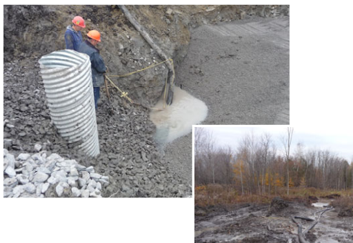
Photo G.1 : Pompage du fond de fouille et rejet dans la végétation, projet de la ligne Chénier-Outaouais
