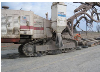
Photo H.2 : Utilisation de pneus pour protéger la chaussée lors du passage d'une foreuse
