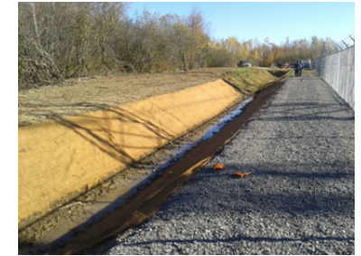
Photo F.6 : Protection des sols à l'aide de matelas anti-érosion, projet du poste de Beaupré
