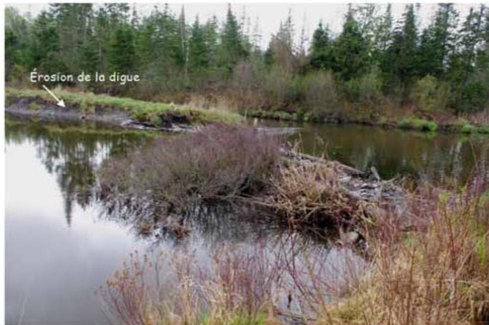
*Photo 3 Érosion de la partie amont de la digue gauche à proximité du déversoir.*
