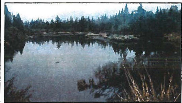
Amont de la digue
