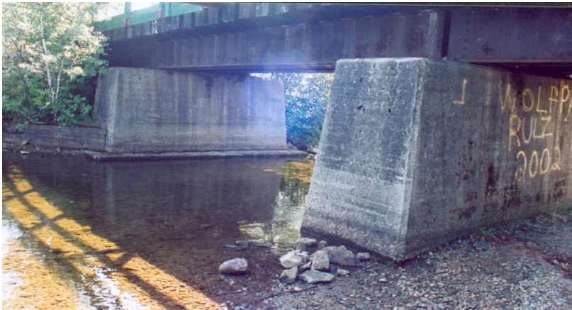
Photo # 2 prise en août 2002, en amont du pont.
