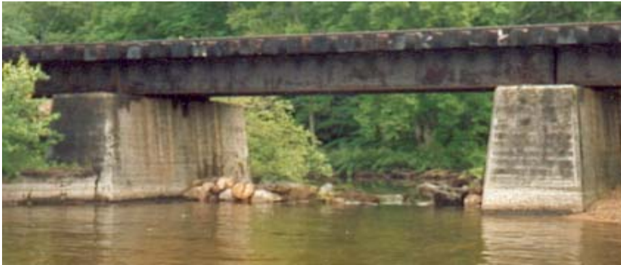
Photo # 1 prise en été 1998, en amont du pont.
