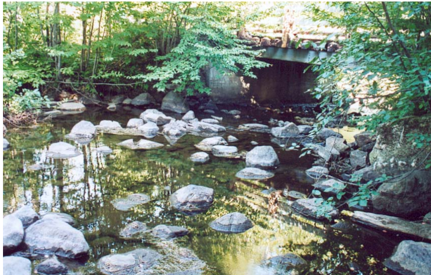
Photo prise en août 2002, en amont du pont.
