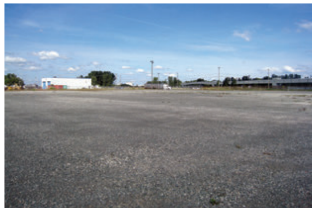
Photo 9 - Lot 3 294 073 – Lieu d'entreposage, propriété d'Arrimage QC. Surface asphaltée autour de l'entrepôt et nivelée avec du gravier – Vue vers l'ouest (SLNGaz14-N1-032)
