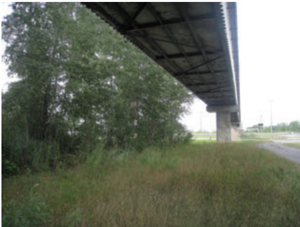
Photo 6 - Lot 3 294 072 – Extrémité est du lot près du convoyeur – Vue vers l’est (SLNGaz14-N1-056)
