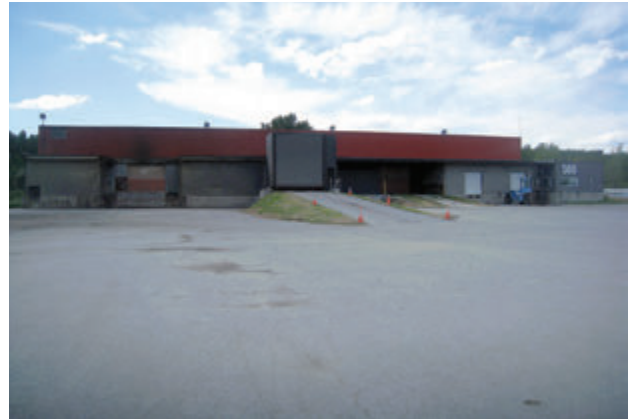
Photo 8 - Lot 3 294 073 – Lieu d'entreposage, propriété d'Arrimage QC. Surface partiellement asphaltée et compactée avec du gravier – Vue vers l'est (SLNGaz14-N1-039)
