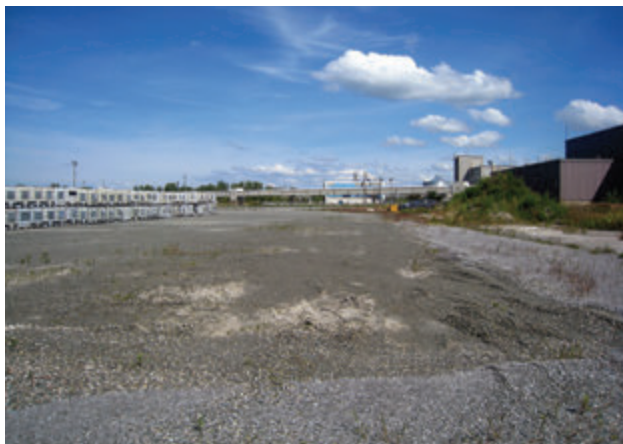
Photo 3 - Lot 3 294 071 – Vue d'ensemble du lot à partir du 3 294 073. La surface actuelle est nivelée et compactée avec du gravier – Vue vers l'est (SLNGaz14-N1-026)
