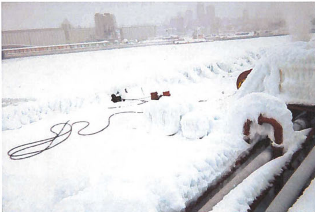
Figures 5.3F – Pont, tuyauterie et soupapes inaccessibles
