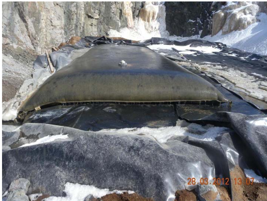
Photo 16-3 : Géotube en opération sur le site de Sheldrake (Source : AXOR)
