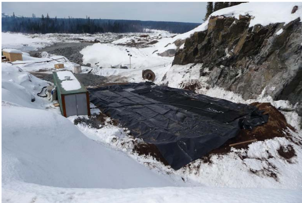
Photo 16-1 : Site de traitement par géotube du site de Sheldrake avant sa mise en opération (Source : AXOR)
