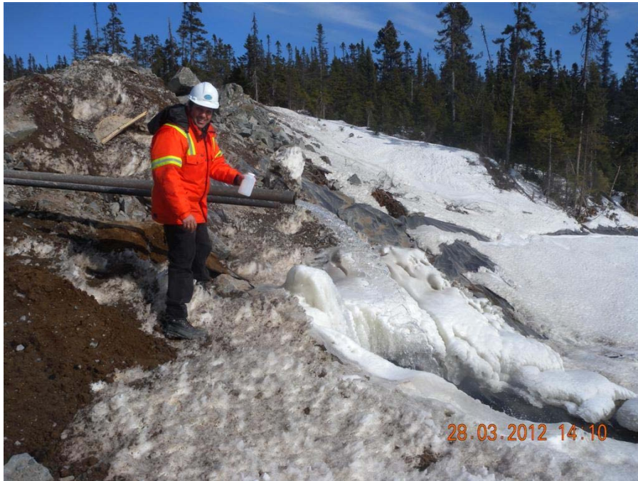
Photo 16-4 : Prise d'un échantillon de l'eau pompée à la sortie du géotube avant d'être retournée à l'environnement sur le site de Sheldrake (Source : AXOR)
