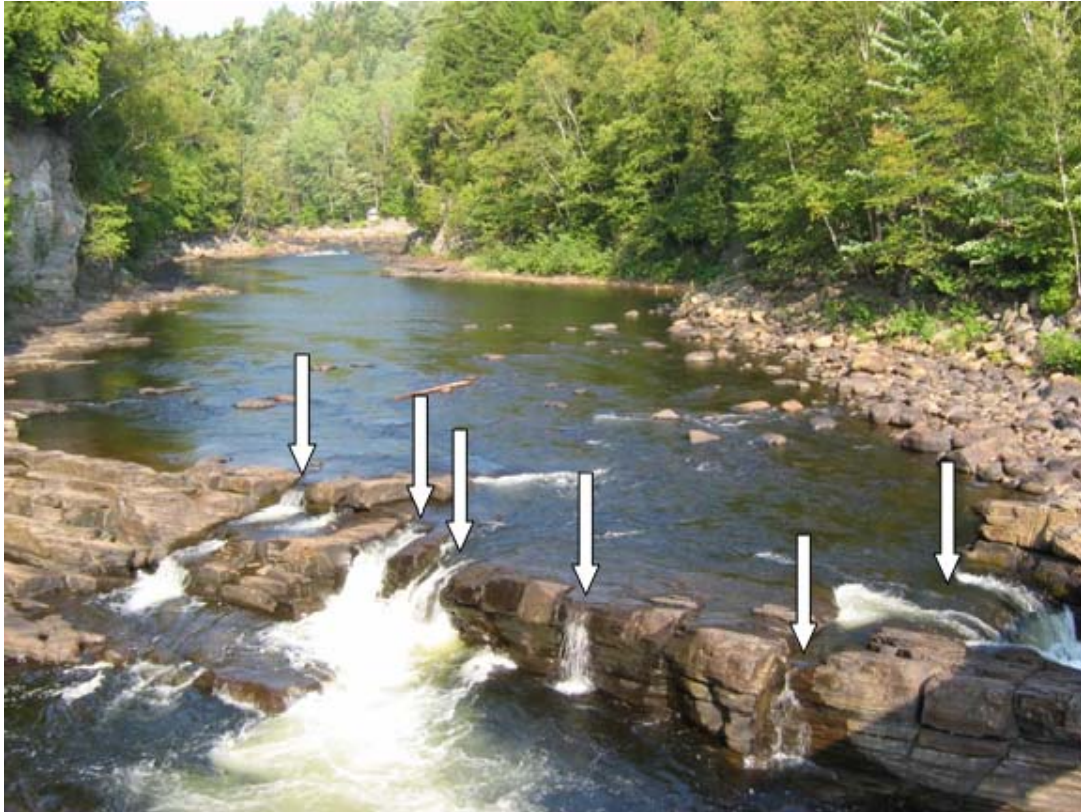
Photo 3-4 : Seuil naturel de bief intermédiaire et flèches indiquant les échancrures du seuil SH10 (vue du Pont Mestachibo)
