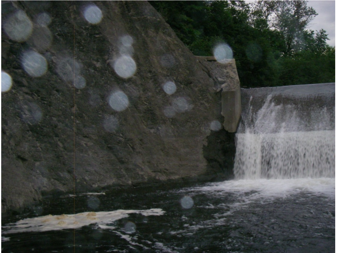
Photo 4-2 : Rive droite du barrage de l'Abitibi Bowater
