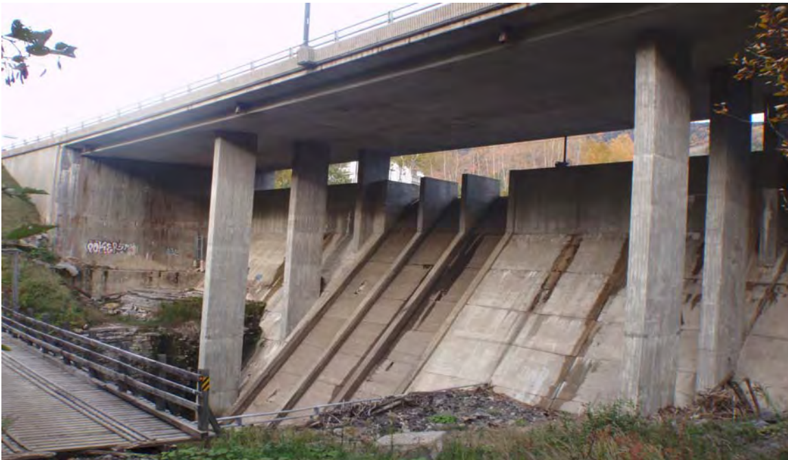
Barrage Simard sous le pont Antoine-Bélanger. Ce barrage ferme la vallée de la rivière Jean-Larose, un affluent rive droite de la rivière Ste-Anne-du-Nord en aval de la centrale projetée et en amont du barrage d'Abitibi-Bowater. Ce barrage qui a servi à la création du lac du Mont Ste-Anne présente de nombreux problèmes de sous-écoulements liés à la présence de phénomènes karstiques dans les fondations calcaires.
