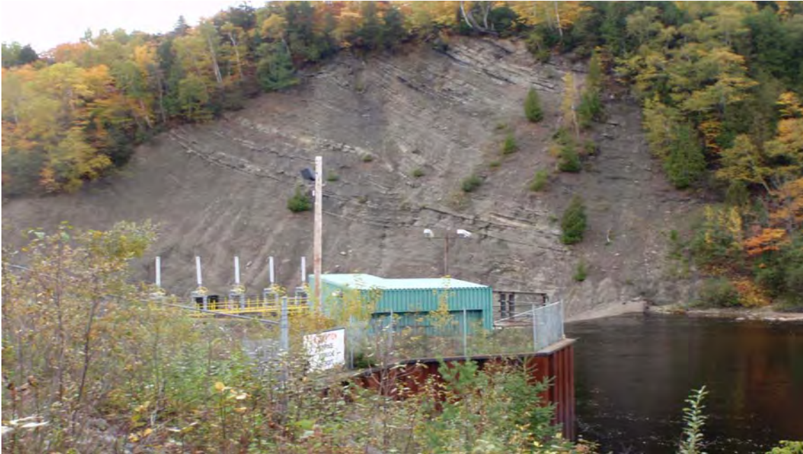
Prise d'eau de la ville de Beaugré située en rive gauche de la rivière Ste-Anne-du-Nord, immédiatement en amont du barrage d'Abitibi-Bowater. À noter les schistes d'Utica en rive droite.
