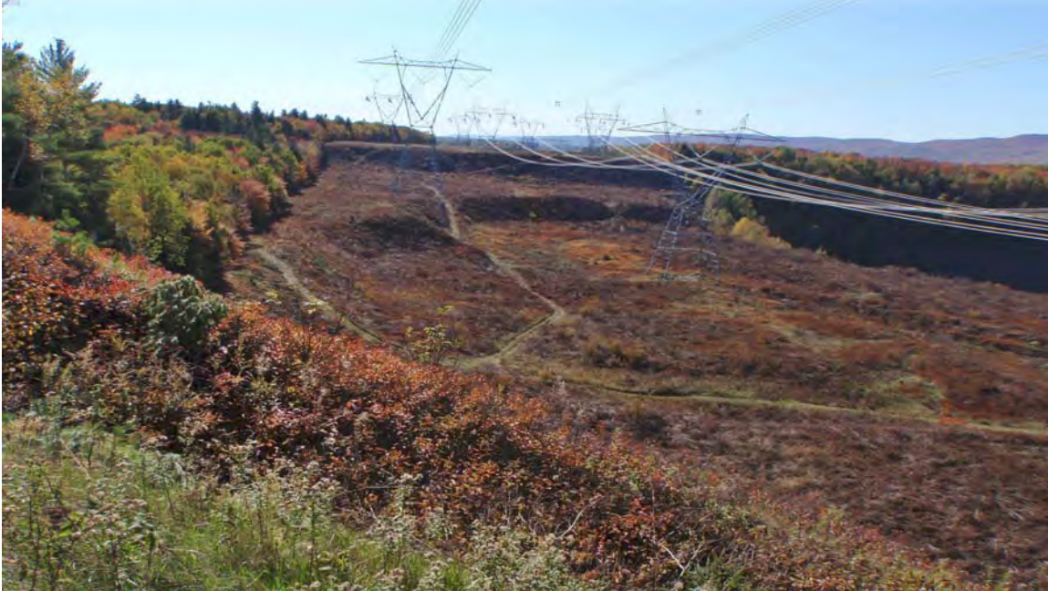
Corridor des lignes de transmission à 735 kV de TransÉnergie vu vers le sud-ouest à partir de la route d'accès au site récréo-touristique Canyon Ste-Anne. À noter les terrasses étagées. Des travaux de déboisement du corridor avaient cours lors de notre passage.
