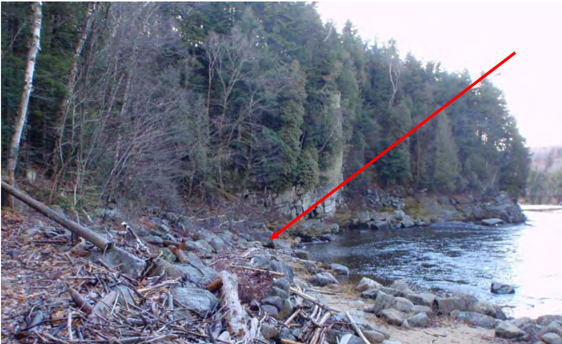
Zone rive gauche du barrage et de l'évacuateur de crues avec, à l'aval, l'escarpement rocheux contenant la partie amont de la conduite d'amenée. À noter la bande de blocs riverains en amont. Vue vers l'aval.
