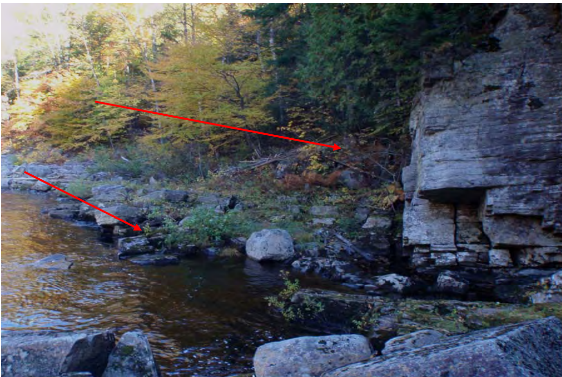
Secteur du barrage rive gauche et de l'évacuateur de crues. À noter les blocs en rive et le talus de blocs plus haut. À noter également le mode de fracturation de l'escarpement à droite. Vue vers l'amont.
