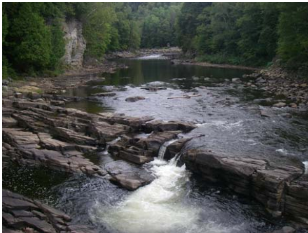
Photo 7-13 : Seuils naturels de contrôle hydraulique à la sortie des segments SH10 (a) et SH12 (b) dont les échancrures seront bétonnées afin de maintenir la superficie mouillée en amont en phase d'exploitation.
