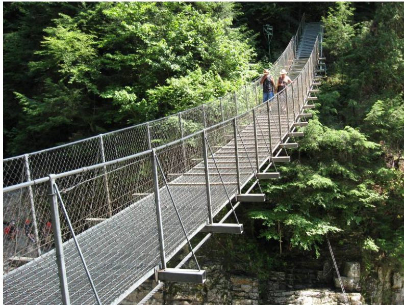
Photo 7-14 : Passerelle Laurent du Canyon Sainte-Anne
