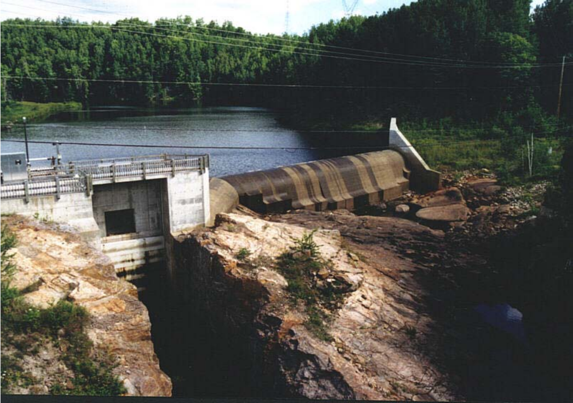
Système de porte électrique et de seuil déversant similaire à celui prévu à Saint-Joachim (parement d'encrochement en moins).
