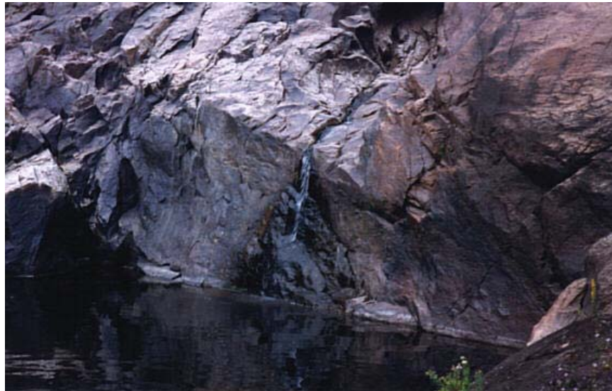
Filet d'eau résiduel au pied de la chute lorsque la centrale fonctionne.
