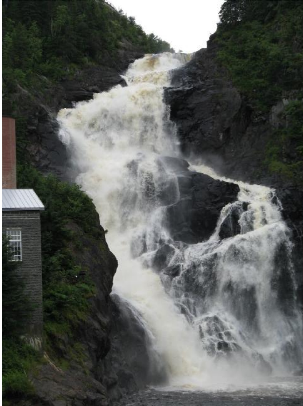
Vue de la chute Quiatchouan menacée, près du Vieux Moulin.
