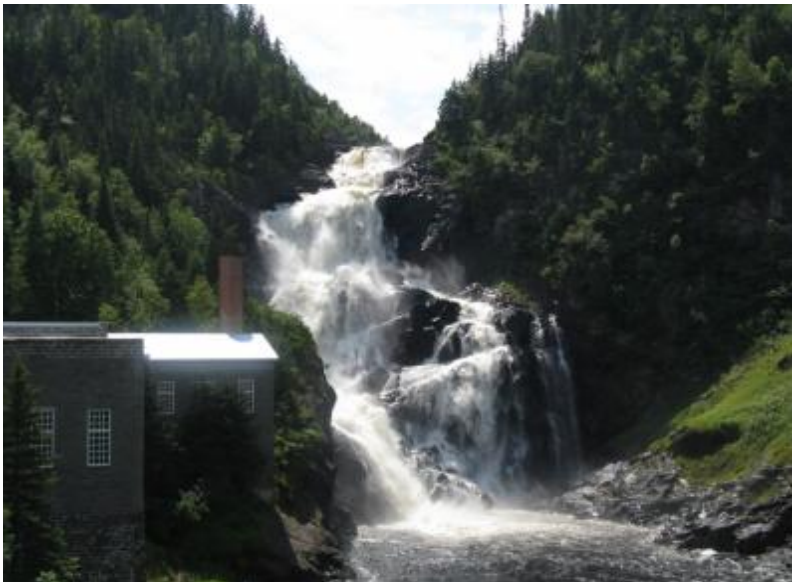
Vue de la chute au débit de 7 \text{ m}^3/\text{s} .
